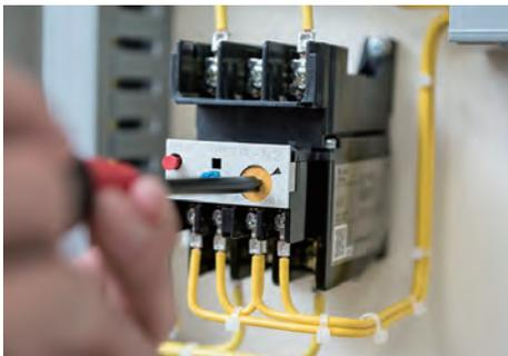
◇ 49M を三相誘導電動機の定格電流値（15A：器具の仕様等に準ずること）に設定する。
