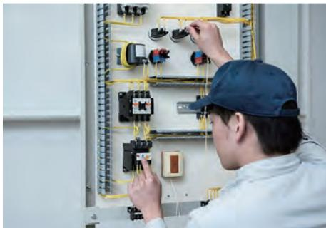
通電しない状態でブザーまたはテストを用い、接続図から動作を読取り器具を操作して回路を確認する。
