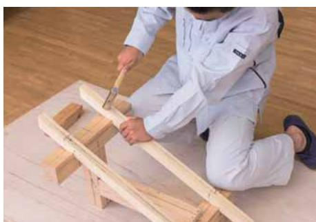
・たる木をむな桁と桁に釘で固定する。
