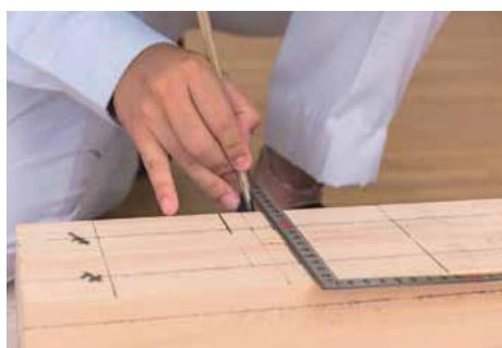
・左右の間隔芯墨から両側へ15mmずつ、たる木幅墨を付ける。
