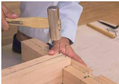
・はりとむな桁との取付部にきりで穴をあけた後、釘で固定する。
