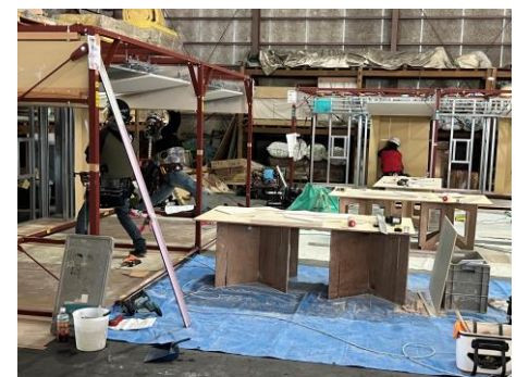
《新産住宅(株)_建築大工》
