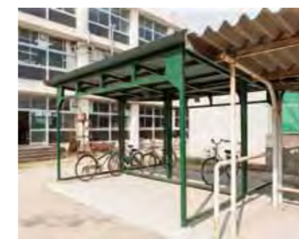
校内に必要なものはできる限り自分たちで作っている。駐輪場の組み立てに溶接が用いられた。
