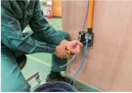
各ケーブルを配線後、同軸ケーブルの外被を除去する。
