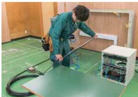
光ケーブルの被覆除去長さを測定し、被覆除去開始位置を決定する。切断位置に白ペンで目印をつける。
