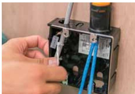
ラベルに「ケーブル No. / ポート No.」を記載し、U/UTP ケーブルと同軸ケーブルに取り付ける。
