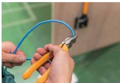
U/UTP ケーブルを折り曲げ、先端にマーキングする。
