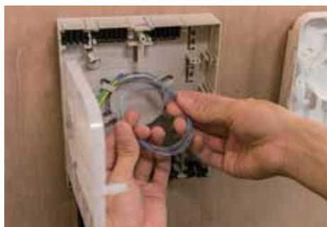
接続する光ファイバを除外し、残りの光ファイバを束線する。
