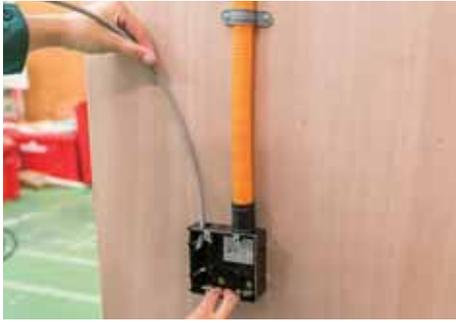
同軸ケーブルを TO から CD 管に沿って配線し、CD 管に結束バンドで固定する。
