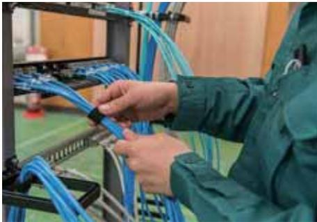
各パッチパネルに接続したケーブルを整線する。
