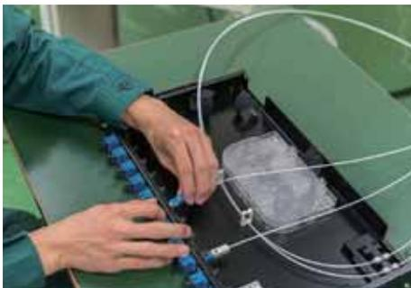
ダクト経由で、2本のインドア光ケーブルを背面から引き込み、SCコネクタで成端する。
