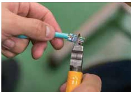
ロードバーの先端位置で心線を切断する。
