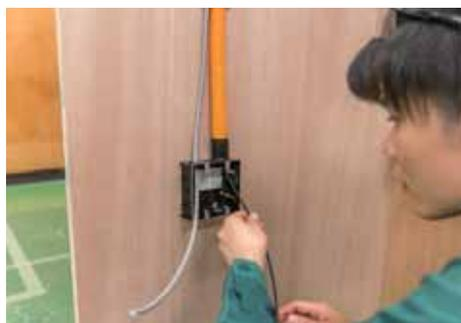
CD管にケーブルを配線するため、呼び線挿入器をCD管に通す。
