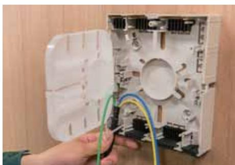
光ケーブルをブース左外面の FODB-3 に取り付け、結束バンドで固定する。
