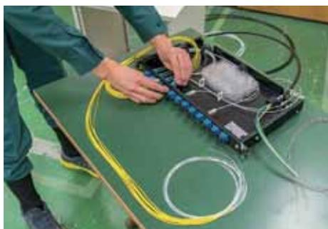
SC コネクタ付光ファイバ心線をパネルの SC コネクタアダプタ内側に接続する。
