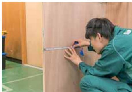
作業板の内面側に指定された情報用コンセント(TO)用のスイッチボックス及びWiFi ルータの取付位置をマークする。
