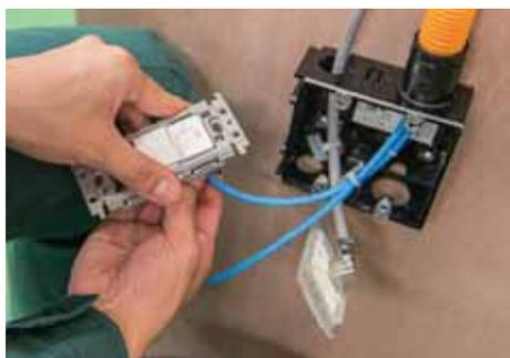
取付枠にTV コンセント、モジュラジャックを取り付ける。
