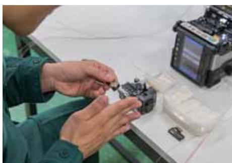
光ファイバの先端を軽く曲げて折れていないことを確認する。
