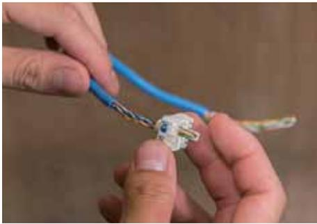
U/UTP ケーブルの外被を除去し、モジュラジャックを成端する。治具を用いてモジュラジャックをしっかりと固定する。
