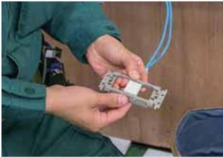
モジュラジャックを取付枠に取り付ける。
