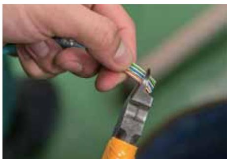
心線を切断して先端をそろえ、2 個目のロードバーを通す。
