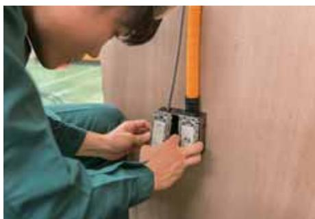
取付枠をスイッチボックスに取り付ける。
