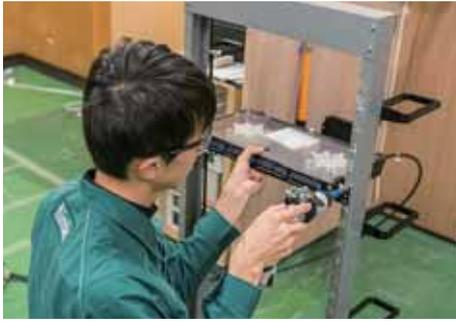
光パネルを 19 インチオープンラックの指定された取付位置に移動し、固定する。
