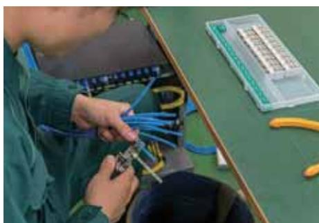
ケーブルラックを通して19インチキャビネットラックに接続するU/UTPケーブルの成端を行う。
