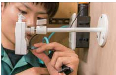
ネットワークカメラに U/UTP ケーブルを接続し、整線する。
