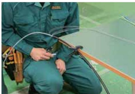
光ファイバをそろえ、スロットロッドの切断位置に印をつける。
