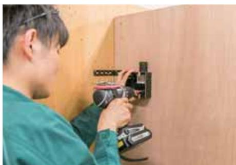
作業板の外面側に指定された TO 用スイッチボックス及びネットワークカメラの取付位置をマークする。水準器でスイッチボックスの水平垂直を確認して固定する。固定後にもう一度確認する。
