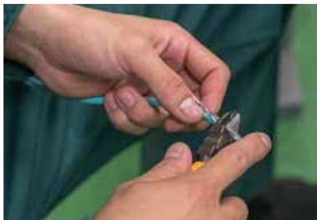
セパレータを根元から切断し、心線を規定の配線順に並べる。順序をそろえてロードバーを通す。
