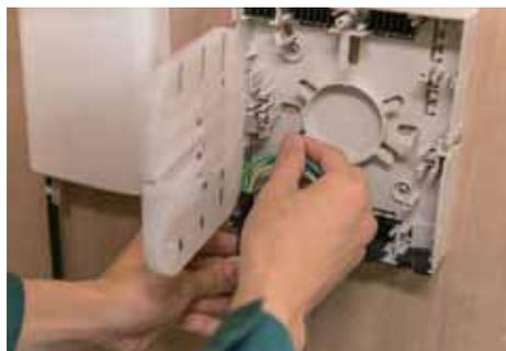
光ケーブルを光接続箱に導入し、結束バンドで固定する。
