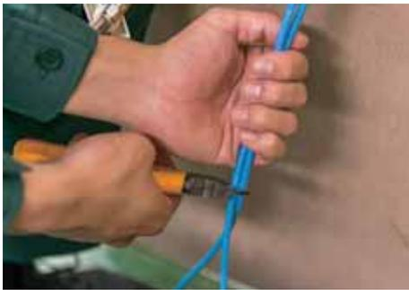
次に、U/UTPケーブルの必要な余長を残し切断する。
