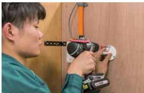
マークした位置にネットワークカメラ取付台を固定する。
