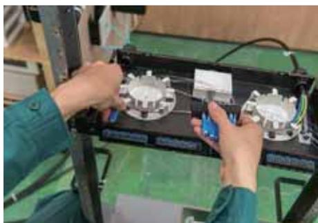
SC コネクタを光パネルのアダプタに差し込み、光ファイバを収納する。必ず光コネクタ部のクリーニングを行うこと。
