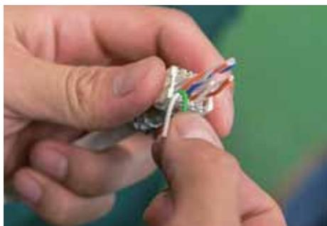
心線を指定位置に取り付け、不要な心線を切断する。
