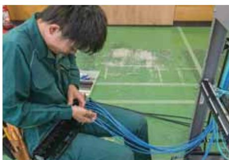
成端したU/UTPケーブルをパッチパネルの背面に取り付ける。
