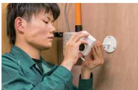
ネットワークカメラを取り付け、電源を供給する。
