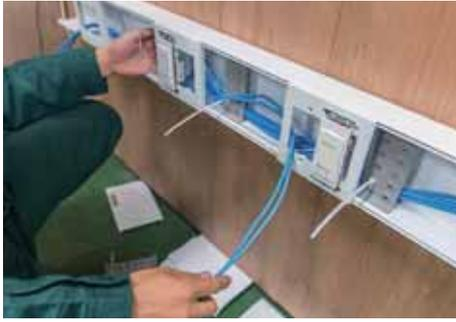
順次、U/UTP ケーブルをダクトに通線・固定し、余分な結束バンドを切断する。
