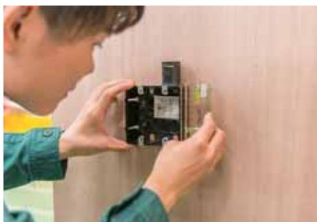
水準器でスイッチボックスの水平垂直を確認して固定する。固定後にもう一度確認する。
