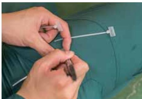
他端の TO 側も同様に、各ケーブルにラベルを取り付ける。
