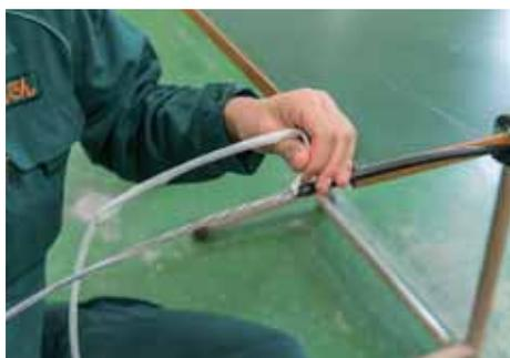
光ファイバを保護している押え巻き紙をはがして、ビニールテープ際で切断する。
