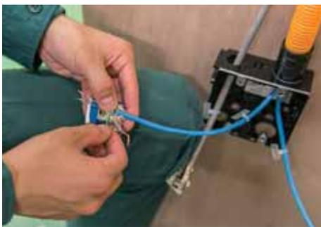
各ケーブルにラベルを取り付ける。U/UTPケーブルの外被を除去し、モジュラジャックに成端する。
