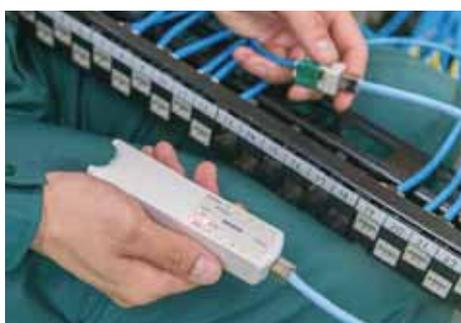
導通試験器で通電することを確認する。
