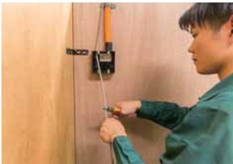
必要な余長を残して同軸ケーブルを切断する。
