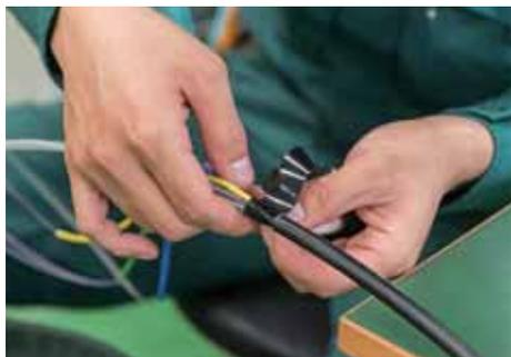
シリコンチューブを外被の根元まで差し込み、テープで止める。
