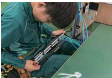
フレームにパッチパネルを取り付ける。
