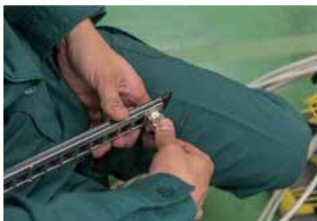
パネルに S/FTP ケーブルを取り付ける。
