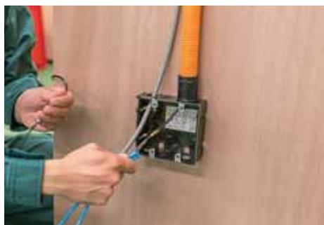
U/UTP ケーブル 2 本を一方の TO 側の呼び線挿入器に引っ掛け、他方の TO 側から呼び線挿入器を引っ張り TO 間に配線する。
