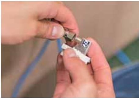
同軸ケーブルのF型コネクタをTVコンセント(端子)に成端する。
