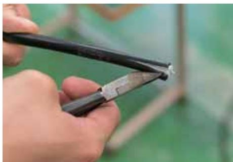
光ケーブル先端部の被覆を除去する。
