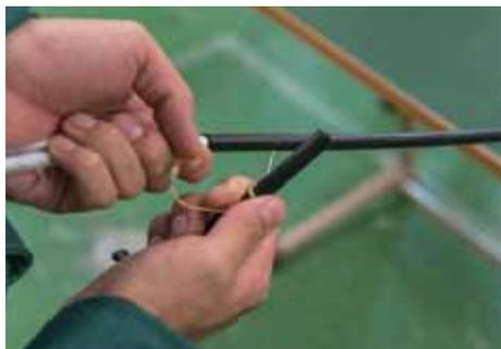
切り取った外被に引裂きヒモを巻き付け、被覆除去位置まで外被を縦裂きする。
