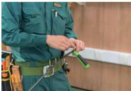
光ケーブルの先端 15 ～ 20cm 位に長手方向及び軸方向に切込みを入れる。
