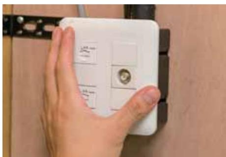
同様に各ケーブルを成端し、TO を組み立てる。
