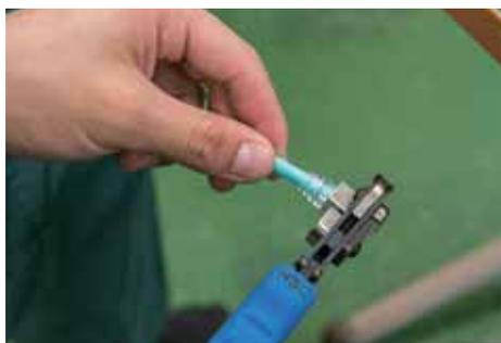
圧着工具で固定する。他端も成端する。
