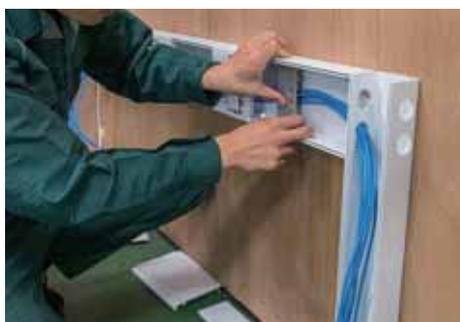
ダクト内ケーブルを配線ダクト用固定具で押さえ、結束バンドで固定する。
