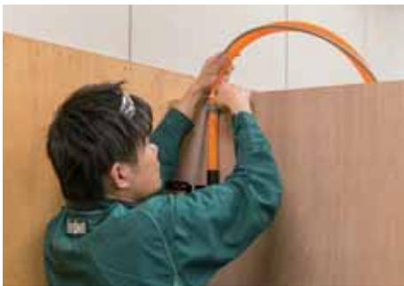
TO 側も同軸ケーブルを結束バンドで CD 管に固定する。結束バンドの不要な部分をニッパで切り取る。
