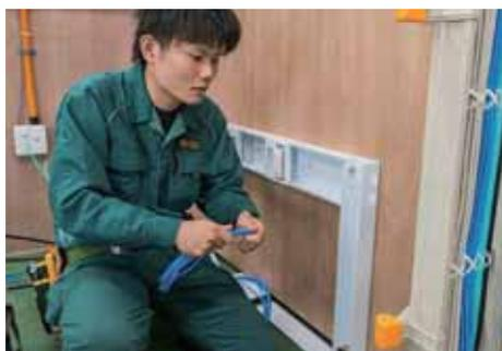
ダクトを取り付けた後、U/UTP ケーブルをダクトに配線する。
