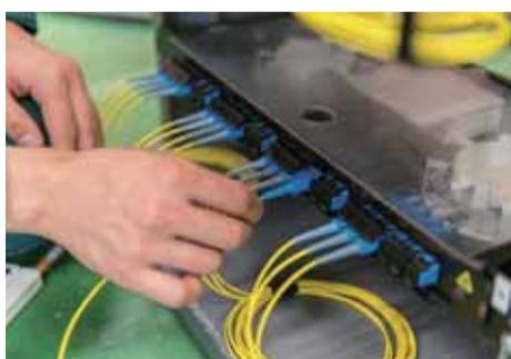
光パネルの端子に光源及び光パワーメータを接続する。光パワーを測定し、光伝送損失を算出する。提出記録用紙に記入する。
