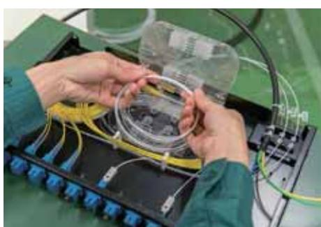
光ファイバ心線を束ね、光収納トレイの溝に光ファイバ心線を挿入する。
