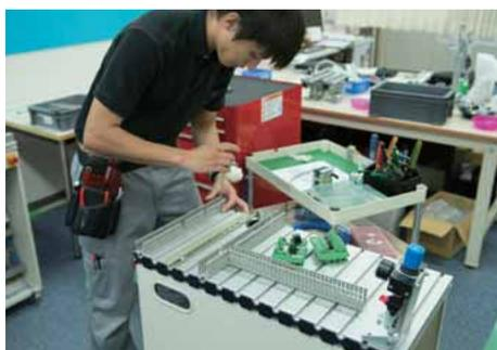
コンベアsta.にケーブルダクト、機器を固定するDINレールを取り付ける。プロファイルパネルのアルミ溝にある2箇所取付穴に固定する。
