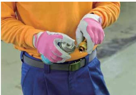
フレア管端部とフレア管継手端部（オス）のシート面、フレア背面に冷凍機油を薄く噴霧する。
