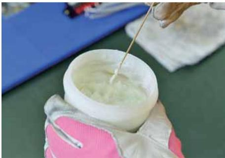
上下の溶接箇所にフラックスを薄く塗布する。
