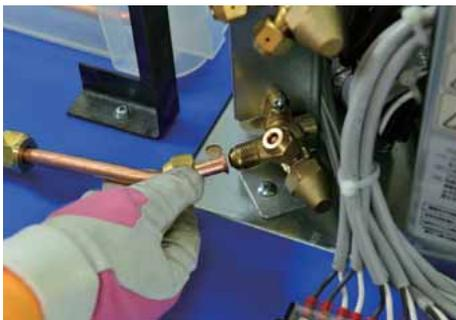
コンデンシングユニットのガス管（下部）にフレア継手で製作したパーツを接続する（ダブルスパナ使用）。
