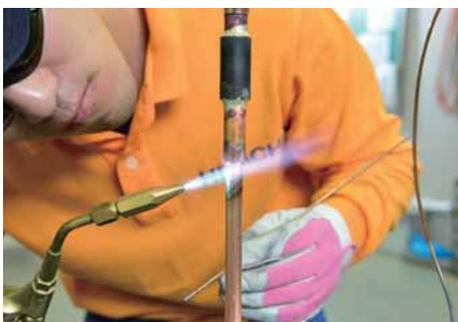
窒素ブローしながら、下部のロウ付け部分をロウ付けする。
