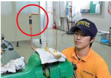
左写真の銅管赤丸部分（下図青色部分）の銅管部を、りん銅ロウを使用してロウ付け接続を行う。
