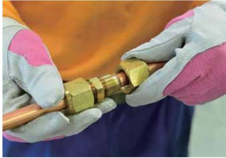
フレアナットの中心を合わせ、手締めでねじ込む。
