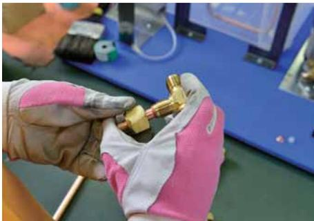
低圧圧力開閉器用圧力取出部のフレア継手に仮固定する。
