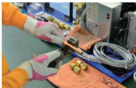
銅管の末端部分は形状が歪んでいるので切断する。
