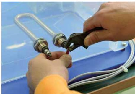
電気ヒータにビニルキャブタイヤ丸形コードを接続する。
