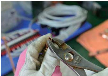
キャピラリチューブを差し込む銅管部分を、プライヤを使用して差し込める程度に潰し、キャピラリチューブをマーキング位置まで挿入し、仮止めする。
