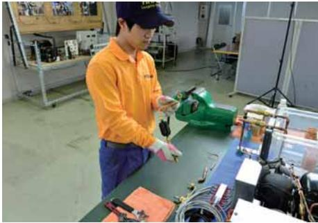
サイトグラスの向きを確認し、確実に締め付ける。
