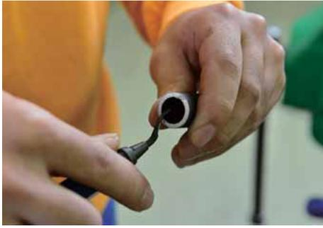
銅管用スクレーパ型リーマを使用して、銅管内面のバリ取りを行う。
