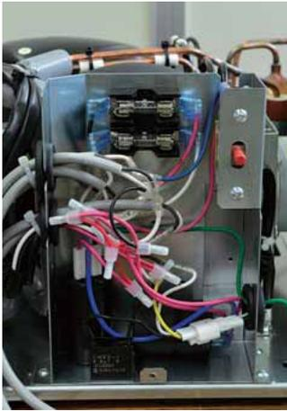
既設制御箱内の既設配線を下図の●部分で切断し、ビニルキャブタイヤ丸形コードを絶縁被覆付閉端接続子で圧着接続し、インターフェイス端子台の指定の端子番号に接続できるようにする。
