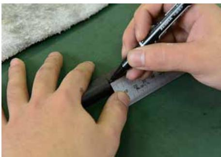
課題寸法の長さを計測し、鋼管の切断位置をマーキングする。
