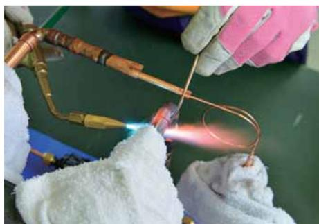
接合部分のロウ付けを行う。ロウ付けしにくい箇所は、必要に応じてロウ棒を曲げて作業する。
