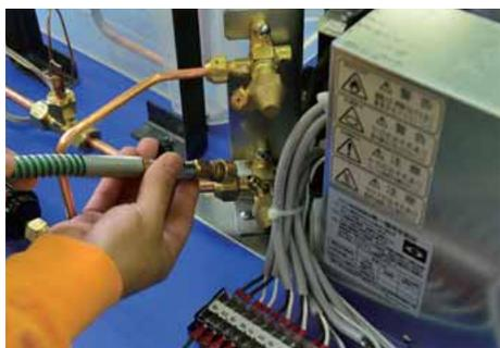
窒素ブロー装置を調整し、窒素ガスが流れていることを確認する。
