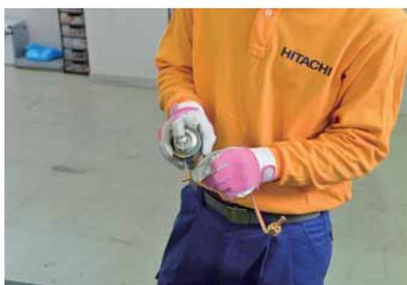
フレア接続部に冷凍機油を噴霧する。
