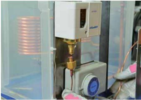
低圧圧力開閉器にフレア継手で接続する。
