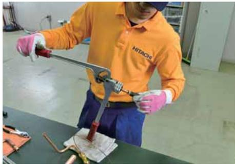
チューブエキスパンダを使用して、接合部の銅管のはまり具合を調整する。
