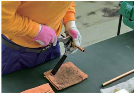
フレア継手をスパナとモンキスパナで押さえて締め付ける（ダブルスパナ法）。
