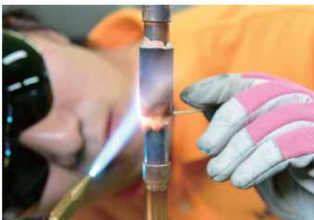
窒素ブローをしながら、上下の接合部を銀ロウを使用してロウ付けする。
