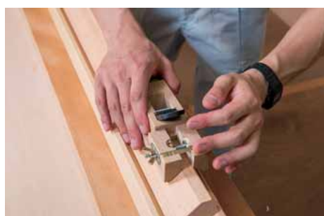
角面カンナを用いて仕上げる。
