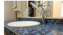
タイル張りの洗面台
