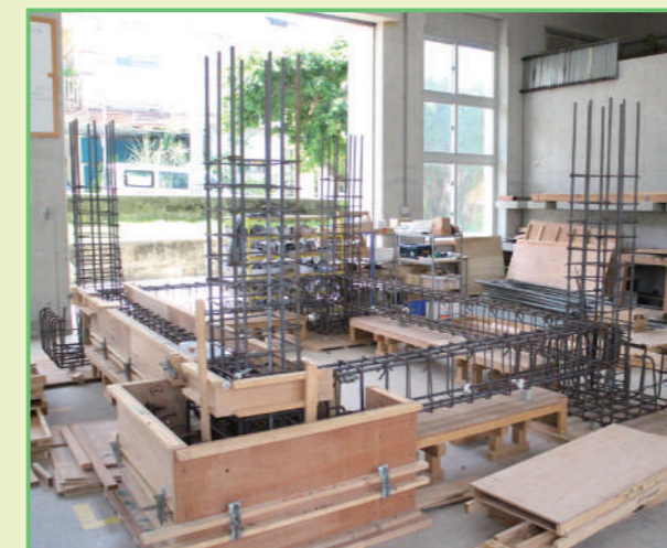
建築科実習場
