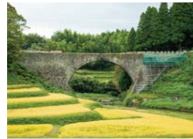
熊本県上益城郡山都町にある国の重要文化財「通潤橋」
