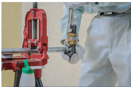
継手の締め込み
