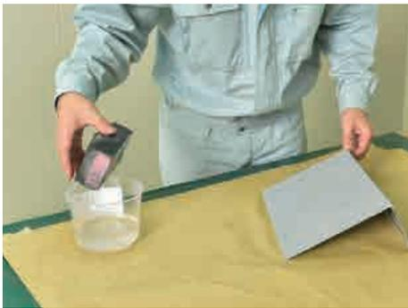
③ 下塗りした面を耐水研磨紙P400を使用して研磨（出来ればあてゴム又はあて木を使用する）し、水研ぎする。
