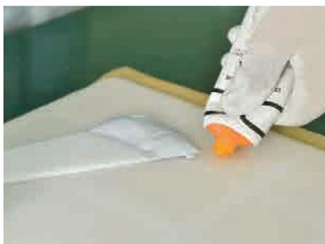
③ パテの主剤と硬化剤を定盤の上に必要量をのせて、へらを使い混ぜ合わせる。
