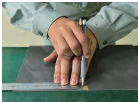
③ 養生する箇所を正確にものさし等で測り、小さく切った養生テープの上に鉛筆で印を付ける。
