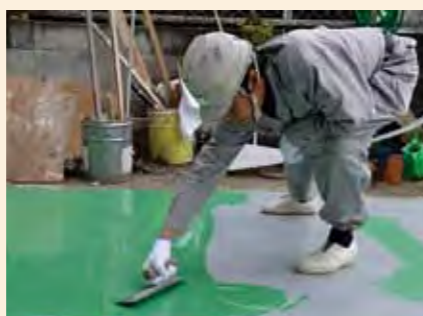
◀エポキシ樹脂剤によるコンクリート床防水施工の例（写真は別場所での試し作業）。主剤と硬化剤を適正に混ぜ合わせた塗床材を、適正量、施工面に流す。それをコテを使い均一にならしていく。材料はセルフレベリングするが、施工面が広ければムラが生じる。塗床材を流す量と的確なコテさばきが技能の1つの要となっている。用途をもとに塗床材を選択して、最適な処理を顧客に提案していくことが重要になる。
