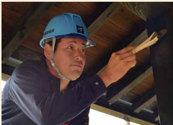
▲建築塗装にはさまざまな機能・用途がある。オーダーに応じて自在に着色をする外観上の用途のほか、防虫、防水、耐火、遮熱等、要求された機能を有する塗料を使用していく。
