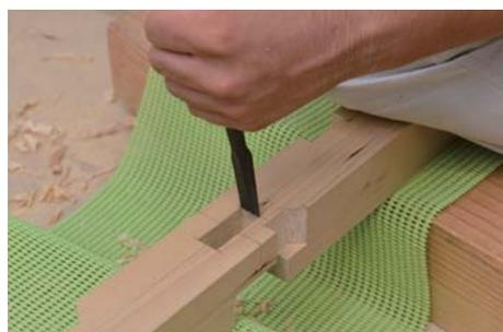
⑤梁の場合、特に、ほぞ穴は正確に。ほぞ穴の長さ方向には少々固めに、幅方向には少々ゆるめに仕上げる（幅が固いと、材が割れる恐れがある）。材料は乾燥材であるが、乾燥度によって細工が異なってくるため、要注意。
