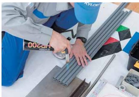
接続部にテープを付けるため、樹脂管を転がしながらトーチランプで均一に加熱する。
