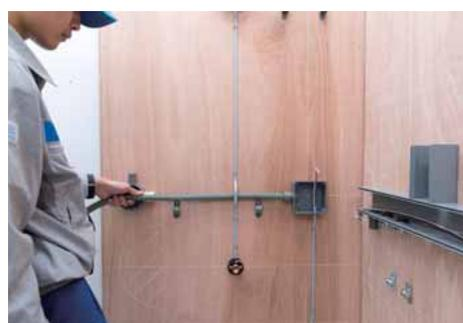
PF管を接続箱に差し込み長さを確認する。サドルで固定した後、余剰部分を切断する。
