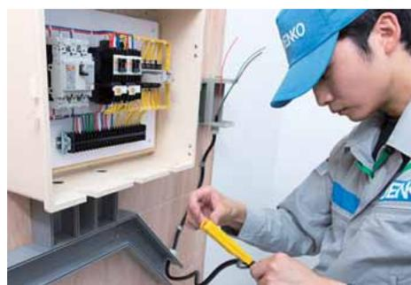
動力制御盤側のCVVケーブルの外装を剥く。
