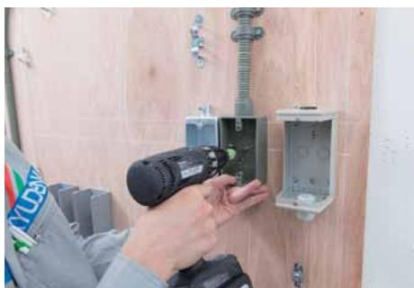
スイッチボックスを取り付け、PF管と接続する。
