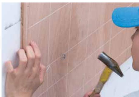
ステップルを仮止めした後、VVFケーブルをステップルに通す。
