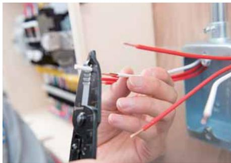
パイロットランプに取り付ける器具の規定に従い電線の絶縁被覆を剥ぐ。
