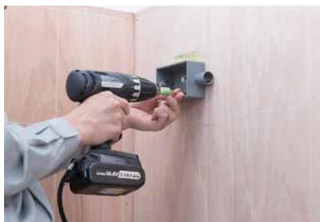
押しボタンスイッチとランプレセプタクルC用のボックスを取り付ける。
