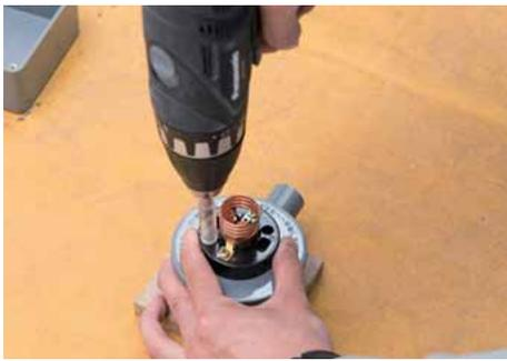
ランプレセプタクルを丸形ボックスカバーの上に載せ、現物合わせで取付穴をあける。
