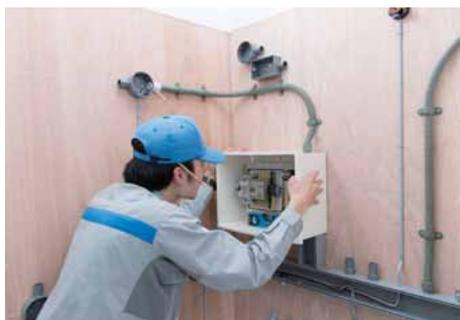
小型PLC制御盤を取り付ける。
