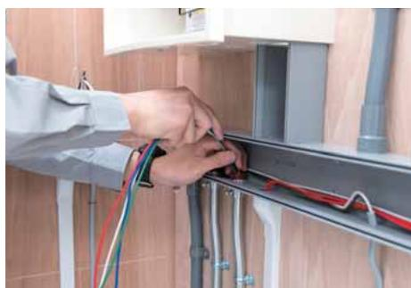
ダクトを経由して、電線を各器具のボックスまで配線する。
