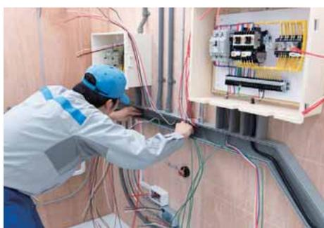
アース線をダクトを通して動力制御盤内に引き込む。
