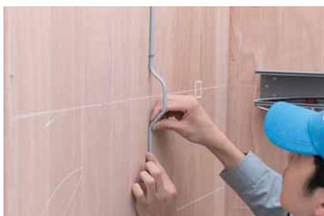
PF管と交差する箇所は、VVFケーブルを浮き上がらせる。
