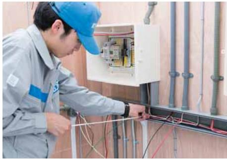
小型PLC制御盤に配線された信号線をダクト経由で配線する。
