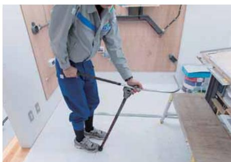
管が作業板と平行になるように曲げる。
