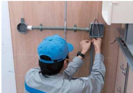
左側面作業板の電源コンセントから接続箱までの配線をして、電源コンセントにカバーを取り付ける。
