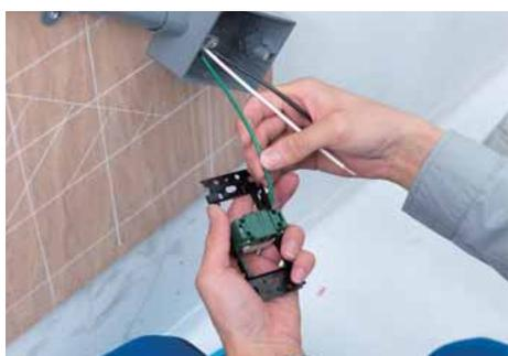
コンセントに電線を接続し、ボックスに取り付ける。
