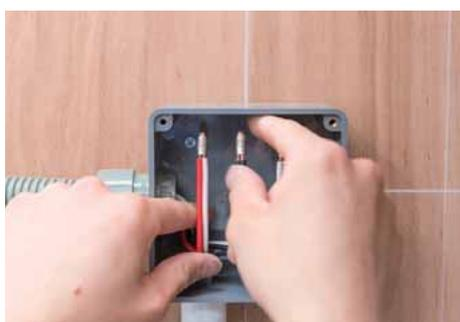
接続部分をボックス内に納めて、絶縁キャップを取り付ける。
