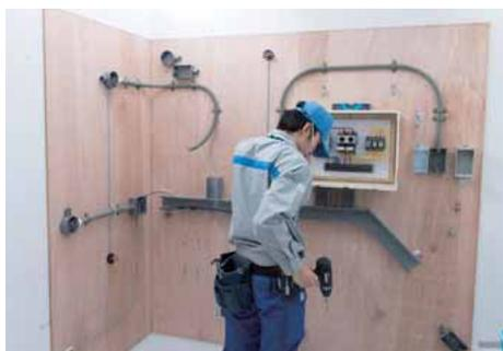
動力制御盤を取り付ける。
