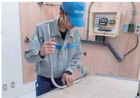
曲げ量を確認する。下の写真は両端を曲げ加工した金属管。
