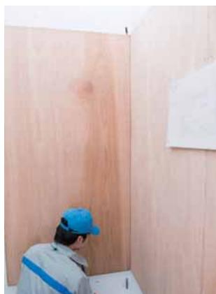
左側面作業板も同様に垂線をとる。下部に印を付ける。
