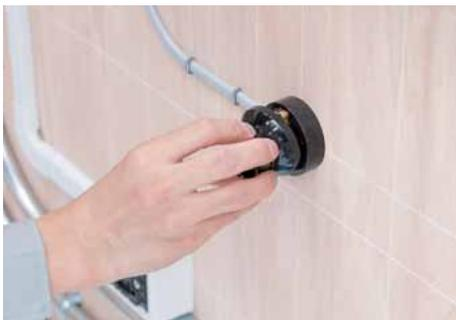
ランプレセプタクルにカバーを取り付ける。
