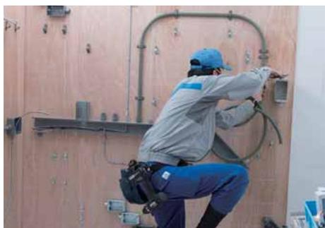
PF管をスイッチボックスまで配管した後、余剰部分を切断する。
