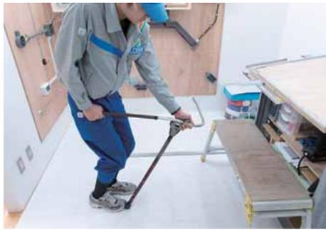
金属管の反対側の取付口も同様に曲げ加工する。
