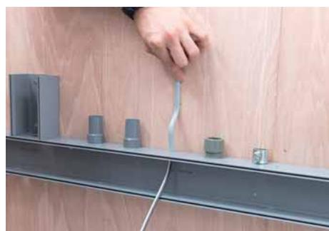
ダクト穴は作業板から浮いた位置にあるので、VVFケーブルを曲げてステップルで固定する。
