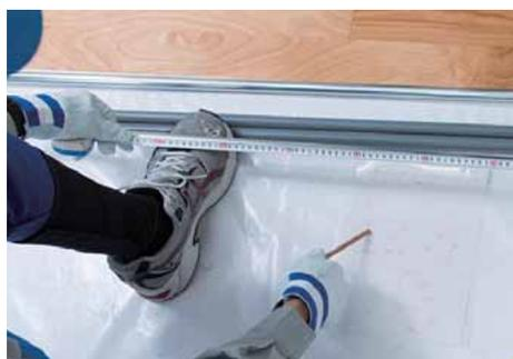
読図の工程で縮みなどを考慮して計算した長さを測り、金属管の切断箇所に印を付ける。
