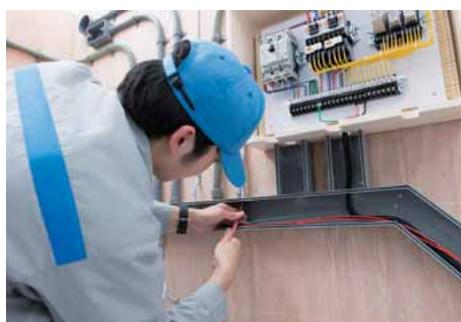
電線の先端を折り曲げ、ダクト側から金属管に電線を押し込む。パイロットランプ取付ボックス側から出てきた電線を引き出す。
