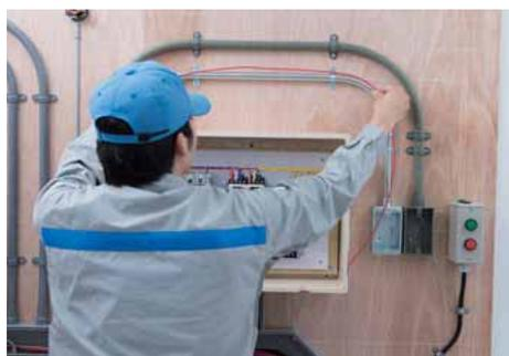
金属管に沿わせて動力制御盤の絶縁電線の必要長さを測る。
