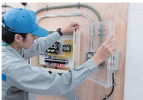
動力制御盤及び小型 PLC 制御盤にカバーを取り付ける。
