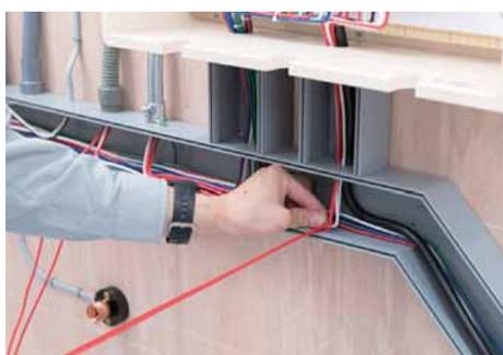
各ボックスから配線された信号線を動力制御盤に引き込む。
