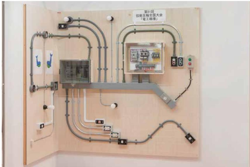
製作する課題は、動力制御盤による 2 個のモータの駆動と、小型 PLC 制御盤による電灯の点灯という 2 系列の電気回路で構成されている。
