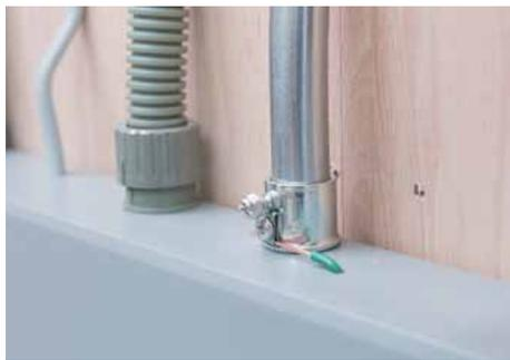
最後にねじを締めてねじ切りを行い、金属接触でアースが確実にとれていることを確認する。
