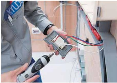
高容量引掛けコンセントに電線を接続し、ダクトに取り付ける。
