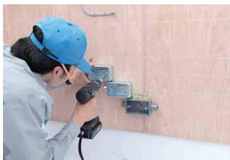
押しボタンスイッチ、高容量引掛けコンセントM1、M2用のボックス、ランプレセプタクルBを取り付ける。
