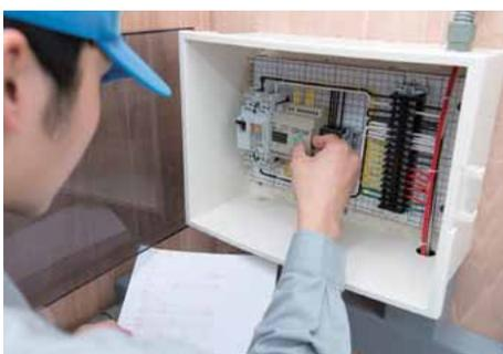
小型PLC制御盤に直接プログラムを入力する。
