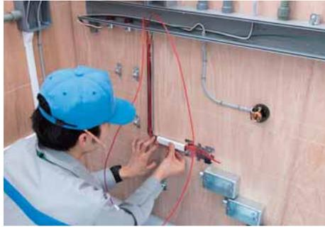
電線を配線し、カバーを取り付ける。
