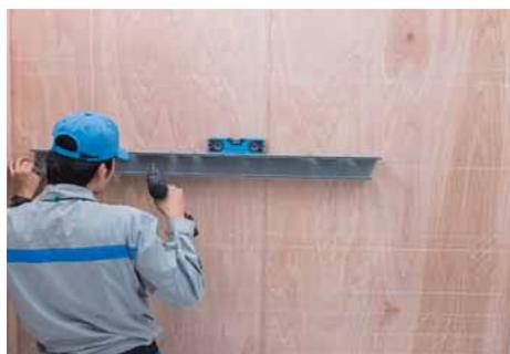
水準器を用いてダクトを水平に取り付ける。
