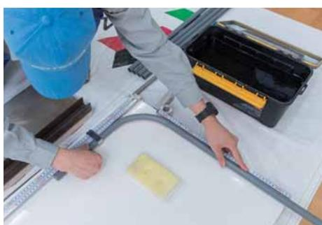
加熱した合成樹脂管を固定し、曲げRに合わせて作業板に押しつけてゆっくり曲げる。
