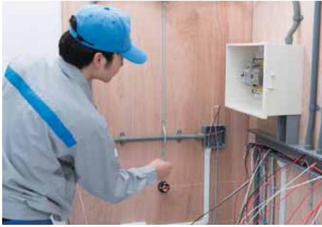
同様に接続箱と接続箱との間のPF管にも電線を通す。
