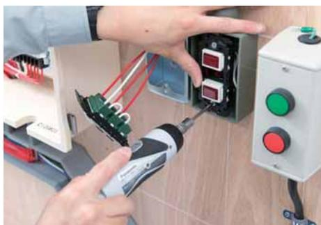
パイロットランプをボックスに取り付ける。
