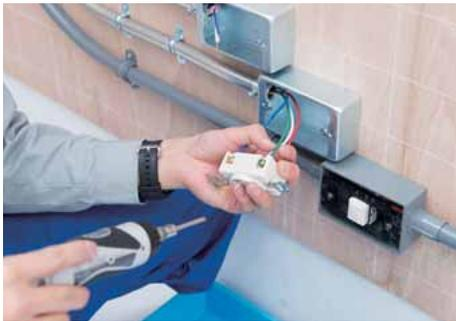
高容量引掛けコンセントに電線を接続し、コンセントのボックスに取り付ける。
