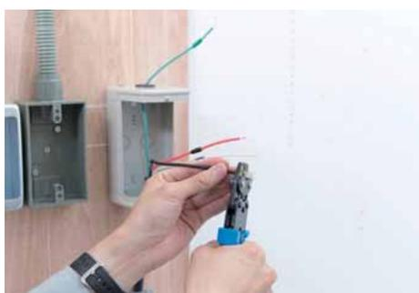
押しボタンスイッチ側の電線の絶縁被覆を剥ぎ、より線に圧着端子を取り付ける。
