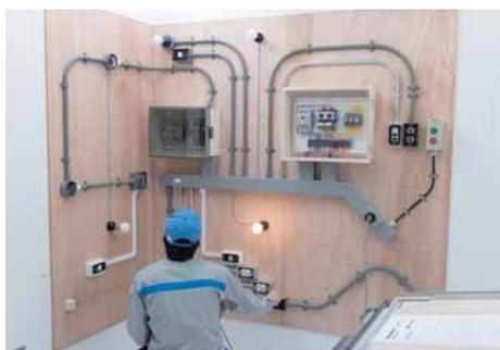
PLCをRUNモードにして、電球の点灯順序、点灯時間がタイムチャートどおりであることを確認する。
