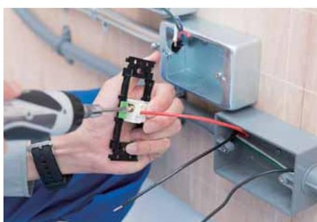
100V 用押しボタンスイッチに電線を接続し、ボックスに取り付ける。
