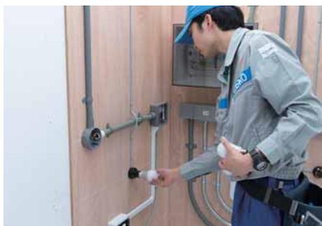
ランプレセプタクルに電球を取り付ける。
