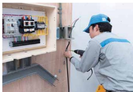
押しボタンスイッチ側からCVVケーブルをサドルで固定し、ダクトを経由して動力制御盤まで配線する。
