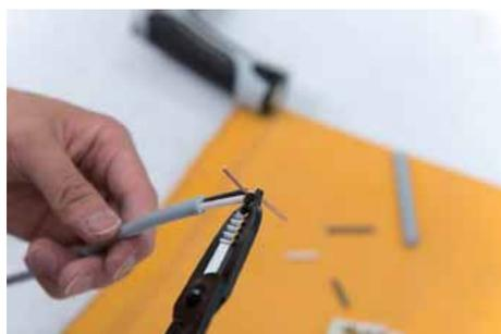
絶縁被覆を剥いだ単線の根元を曲げて輪づくりした後、コンセントの取付位置に合わせる。
