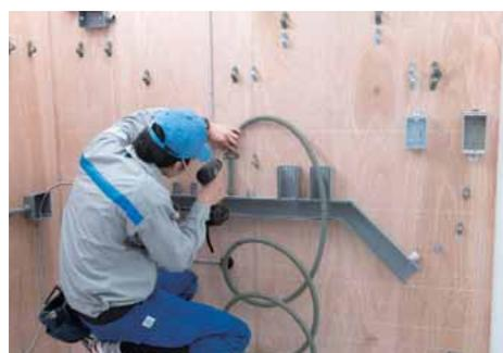
ダクト側にPF管を差し込み、サドルでPF管を固定する。
