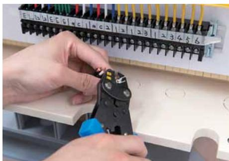
絶縁被覆を剥がし、より線に圧着端子を取り付ける。
