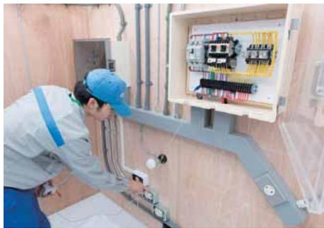
動作完了後、動力制御盤のアースとコンセント及び各部のアースが接続されているかを導通テスターで確認する。
