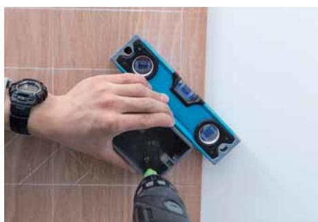
器具の取付けが斜め45度の埋込み接地コンセントは、45度の角度を測定できる水準器を使用して位置決めし、取り付ける。
