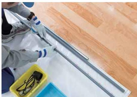
合成樹脂管の寸法を測り切断箇所に印を付ける。
