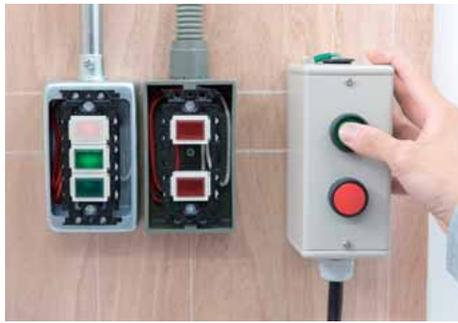
押しボタンスイッチを押して、動力制御盤が検相器を回転させ、表示ランプが点灯するか確認する。
