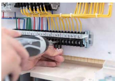
動力制御盤に接続する。
