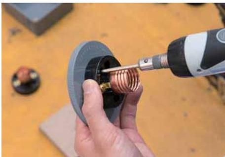
ランプレセプタクルを丸ボックスに取り付ける。
