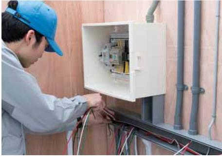
合成樹脂管内を通して小型PLC制御盤と押しボタン間の配線を行う。
