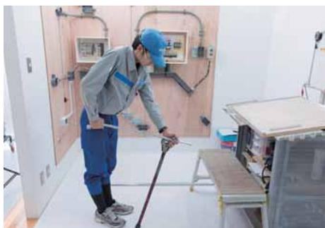
ベンダに金属管をセットし、均一に力をかけて曲げる。
