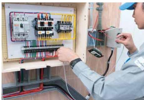
接続後、導通テスターを用いて、動力制御盤とパイロットランプ間の通電を確認する。
