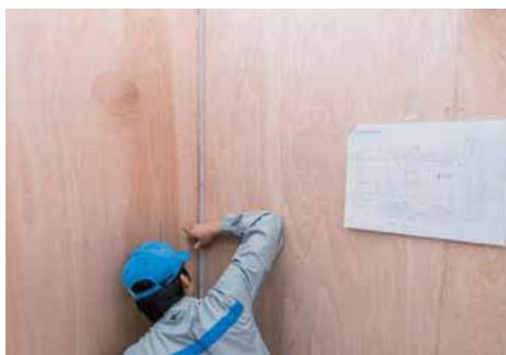
読図の工程で作成した図に基づき、基準点から縦軸の座標位置に印をつける。
