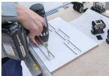
図面に基づきDINレールを制御機器取付用板に固定する。
