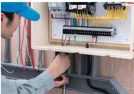
絶縁被覆を剥がした電線を指定された端子台に配線する。
