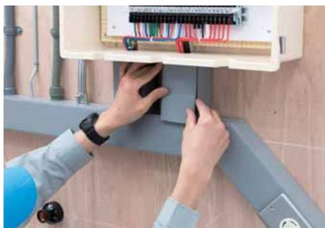
制御盤とダクトの間にカバーを取り付ける。端面はダクト用キャップでふたをする。
