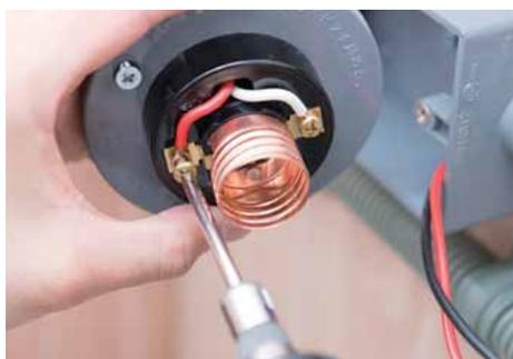
ランプレセプタクルに電線を接続し、ボックスに取り付ける。
