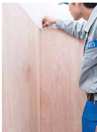
正面作業板の上部に下げ振りを吊り下げ、垂線をとる。
