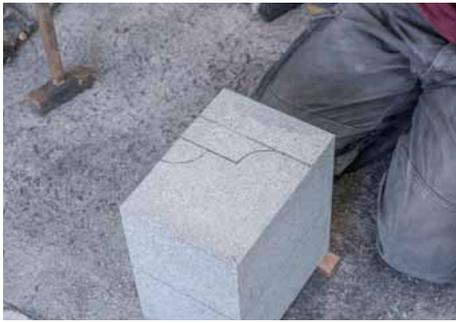
薄くなった切削線を、テンプレートとさしがねを使用し再度墨付けする。
