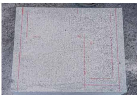
天端面のふち取りの基準線を墨付けする。
