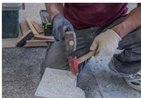
正面の上段凹R角部を、こやすけとせつとうを使用して、左側面から削り取る。
