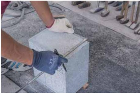
正面部分の切削を行うために、右側面に切削線の墨付けをする。
