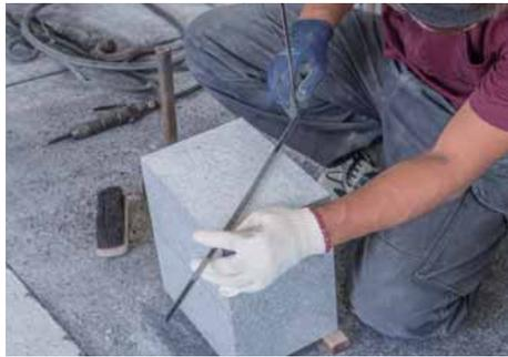
さしがねを使用して平坦さを確認しながら、凸箇所を削り、平坦度の精度を高める。
