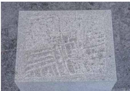
天端面の4辺を墨付け線に沿って正確に削り取る作業を終えたところ。
