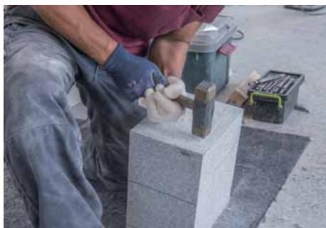
ふち取り線より内側の面を、荒（鬼）びしゃんを使用して、荒く削る。
