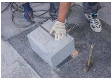
8 枚びしゃんを使用する仕上げ作業のために、天端面のびしゃん仕上げ寸法を墨付けする。
