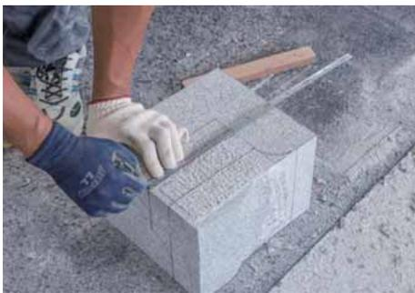
天端面に、正面左側の削り取る部分の墨付けを行う。
