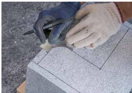
支給のテンプレートを使用して、R部分の円弧を墨付けする。
