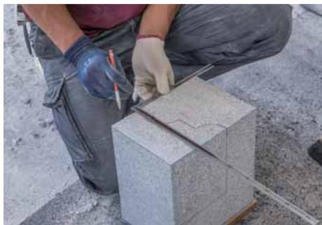
左側面にふち取りの寸法（端から15mm程度）を、さしがねを使って赤鉛筆で墨付けする。
