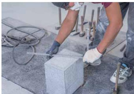
左側面の作品に残る部分の平坦さを、さしがねを使用し
