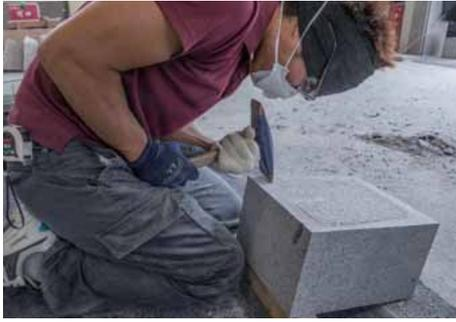
天端面ふち取り部の小たたき仕上げを、両刃（たたき）を使用して行う。
