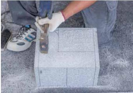
天端面のふち取り線より内側の平坦部を8枚びしゃんを使用して仕上げる。
