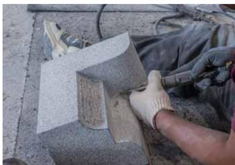
エアコーバによる正面の切削をするために、石の下に枕木を置き、作業しやすい状態に石の角度と向きを変える。正面入隅の切削をする。
