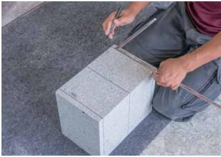
天端面の切削線を、加工しない裏面から順次墨付けする。
