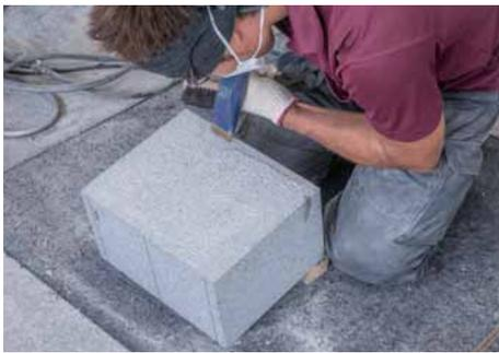
天端面で不自然に見える箇所を、両刃（たたき）と8枚びしゃんを使用して、修正する。
