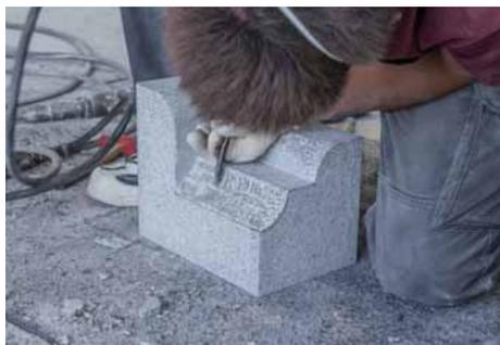
石の向きを変えて、正面の凹R部分をエアーのみを使用して、さらに切削する。
