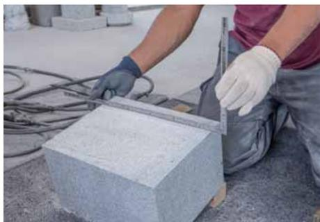
天端面の平坦さを、縦横にさしがねをあてて確認する。
