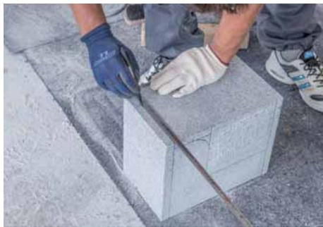
石の正面に、右側面を切削するための墨付けを行う。天端面で行った「面境界部分の切削、面の削り取り」「荒削り、ふち取り、基準面の作製」の各作業を行う。
