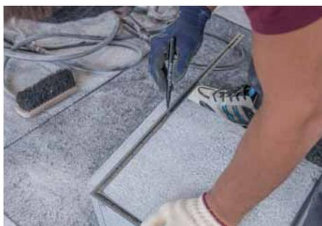
上端面に、正面から削り取っていく分について、正確な寸法を墨付けする。
