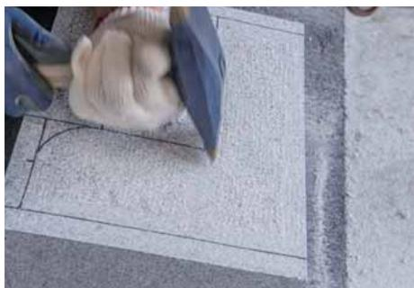
天端面のふち取り部分（15mm）に、両刃（たたき）を使用して小たたき仕上げを施す。
