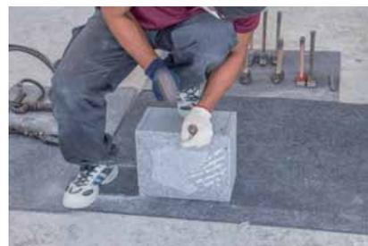
エアーのみを使用して、さらに縦筋に真っ直ぐ削り取る。
