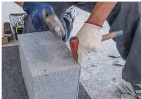
端面と側面のふちを削る。
