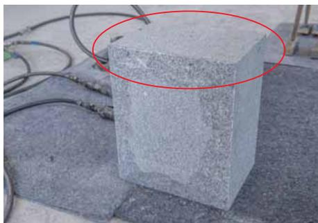
天端面の4辺を墨付け線に沿って正確に削り取る作業を
