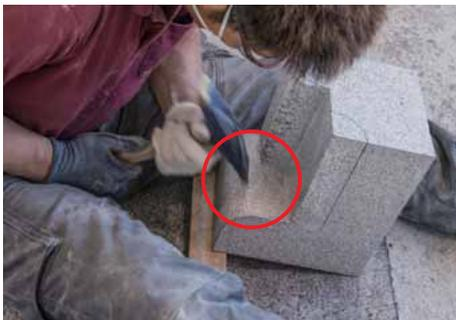
両刃（たたき）を使用して、正面の大きな面（赤丸）部分の小たたき仕上げを行う。
