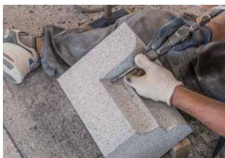
正面上部の凹R面で修正が必要な箇所を、エアこべらで修正する。
