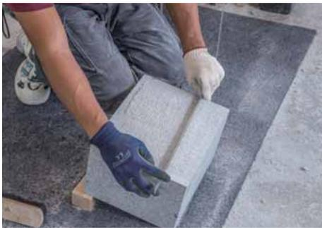
上端面の平坦度をさしがねを使用して確認する。
