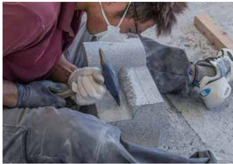
正面下から2段目の大面を、両刃（たたき）を使用して、小たたき仕上げを行う。
