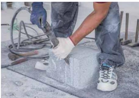
大きな刃のエアのみを使用して、正面の左側部分を削り取る。
