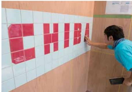
タイルのずれを指先で微調整する。
