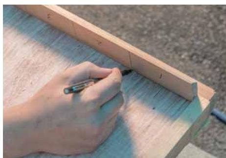
型定規を使用して、タイルの大きさをベニヤ板に写し取る。
