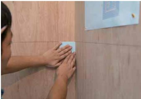
側面の入隅端面にタイルを両面テープで仮止めし、タイルの厚さを確認して正面のタイル割付けをする。
