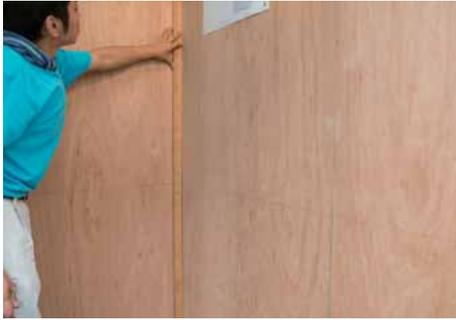
型定規を使用して、正面にタイルの割付け位置を記入する。
