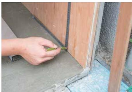
床面タイルの割付けを行うために、正面の垂直墨（正面右側）の位置の印を床面に付ける。
