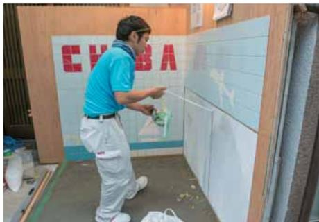
側面及び正面上段と同様に、接着剤塗布、タイル張り、たたき板による接着補強等の作業を繰り返す。
