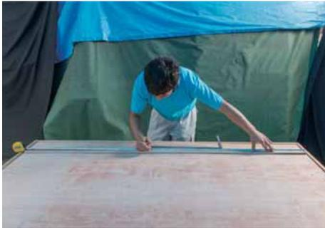
タイルの割付けをするための型定規（目地割り定規）を作成する。
