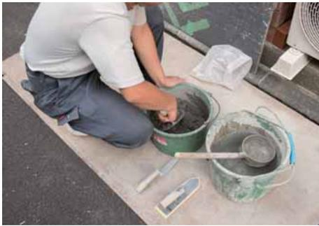
濃灰色の目地セメントに水を加えて良く混合し、目地モルタルを硬めに調製する。
