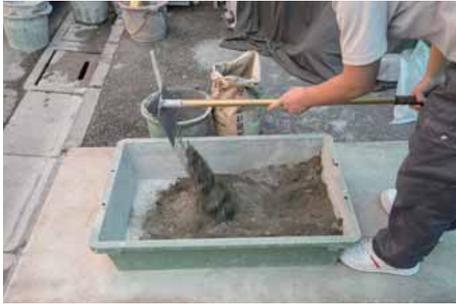
手ぐわを使用して、攪拌混合する。
