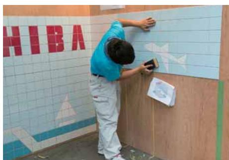
たたき板を用いてたたき、タイルを十分に密着させる。
