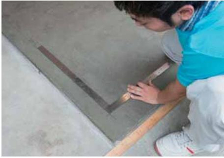
さしがねを使用して床面のタイル端面の直角を確認する。
