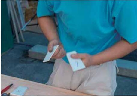
手割り又は押切りカッターを使用して、タイルを切断する。
