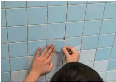
きちんと固定できていないタイルは、接着したタイルを剥がして、接着状態を確認する。
