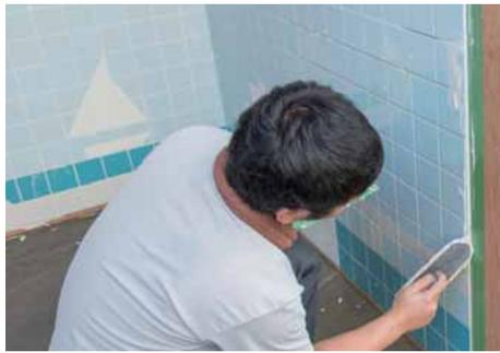
タイルを張り付けた面の側面のコバを塗る。
