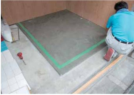
床面の墨出しした線が消えないように、テープで養生する。
