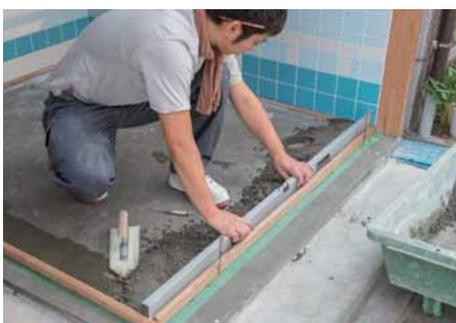
水準器を使用して、水平を確認する。
