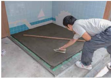
刃定木を使用して、床面下地の平坦度を確認しながら、凹凸部分の微調整を行う。
