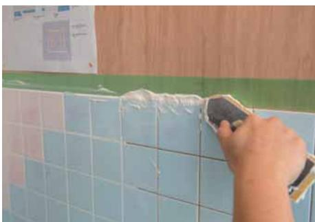
タイルを張り付けた面の上端のコバを塗る。
