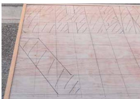
トンネル入口で使用するタイル片の製作図を作成する。
