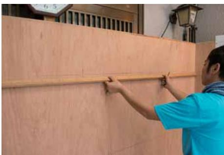
側面上部のタイル割付け位置を、型定規を使用して確認する。
