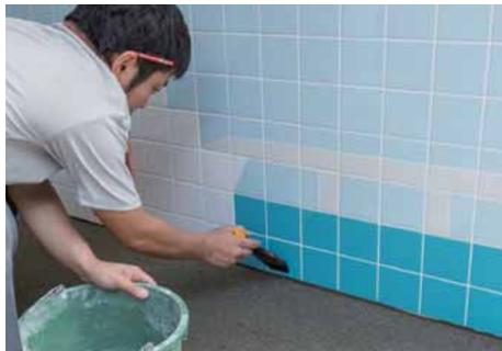
モルタルが乾かないうちに、刷毛やスポンジを使用して、床面の境界部分の壁面タイル表面の清掃を行う。
