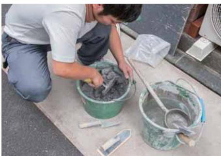
水を加えて、目地モルタルの水分量を調整し、塗りやすい粘度にする。
