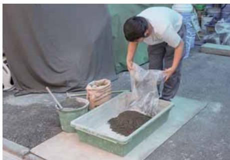
川砂、普通ポルトランドセメント及び水を混練りしてバサモル（敷きモルタル）を調製し、床面の下地に使用する。とろ船に川砂を入れる。
