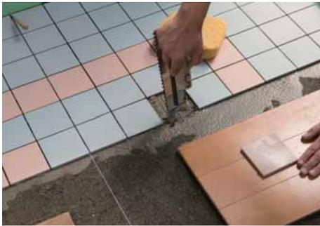
接着の良くないタイルは剥がして、下地を少し削り、再度セメントペーストを敷いて、タイルを張る。
