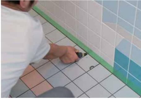
カッターの刃でユニットタイルの連結ネットを切り、目地間隔の微調整を行う。
