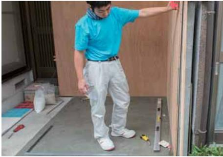
正面のタイル端面の垂直度を下げ振りにより確認する。
