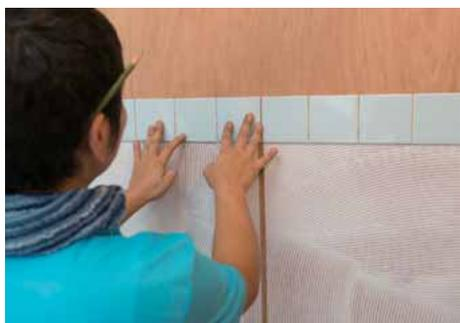
目立たない部分を利用して Tiles の目地幅を調整する。
