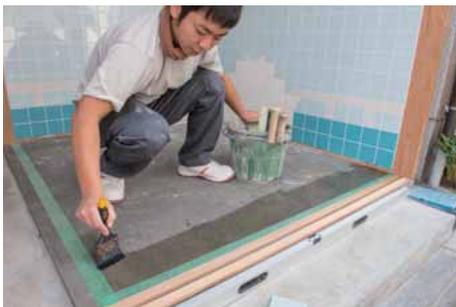
少量の水で、床面の水湿し（軽く水を含ませる）をする。
