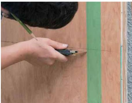
タイル張り作業中、一回に施工する範囲ごとに分けて外せるよう、養生テープにカッターナイフで切れ目を入れる。(P.39、P.46参照)
