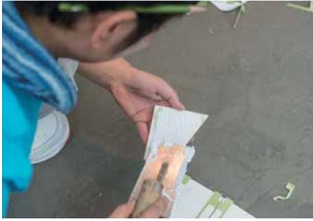
小さく加工したモザイクタイルの接着は、モザイクタイルの裏面に接着剤を塗布して行う。
