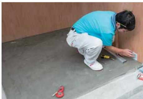
正面に張るタイルの厚みを考慮した上で、地墨にタイルの割付けを行う。型定規を使用する。
