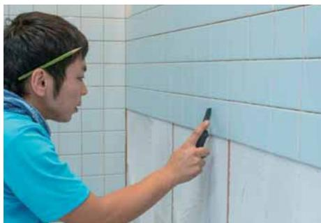
カッターナイフでユニットタイルの連絡ネットを切断し、タイル位置の微調整をする。はみ出した接着剤の清掃も行う。
