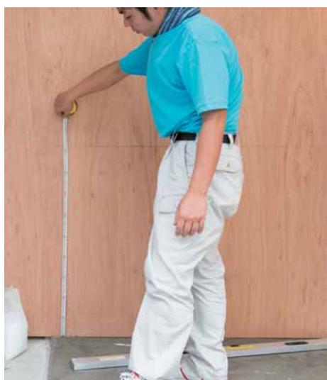
陸墨の高さが割付け寸法に適合しているかを確認する。
