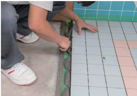
タイルの小口を清掃し、硬めの目地モルタルを床の端面に詰める。
