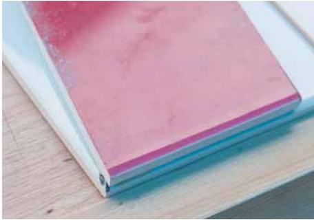
切断加工を行ったレッドのタイルを、これから加工するタイルの上に乗せて、基準点を確認する。
