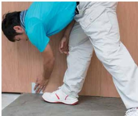
側面に張るタイルの厚みを考慮した上で、床面タイルの割付け（側面左側）の終点を決める。型定規を使用する。
