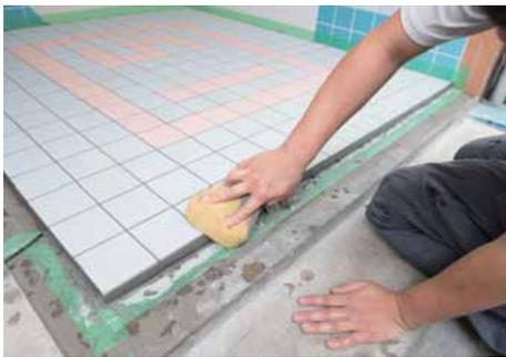
スポンジを使用して、タイルの小口が見えるように清掃する。
