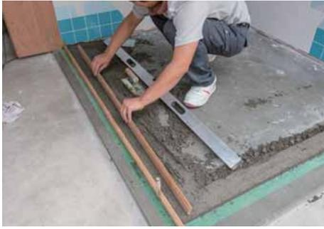
刃定木を利用した定木ずりを行い、下地面を平滑に仕上げます。
