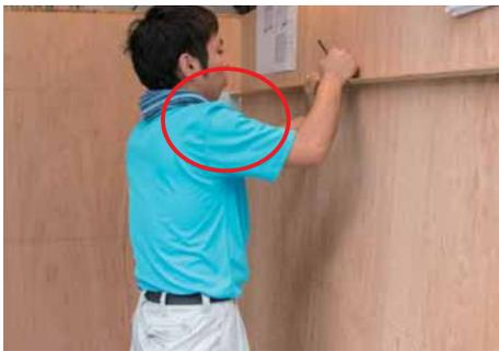
仮止めしたタイルに型定規を押しあてた状態で、正面上部のタイル割付けを行う。
