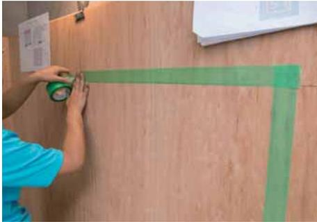
壁面の墨出しした線が消えないように、テープで養生する。
