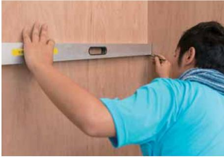
正面の墨出しをするために、側面の陸墨位置を正面に写し取る。
