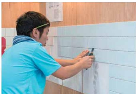
カッターナイフでユニットタイルの連結ネットを切断し、タイル位置の微調整をする。はみ出した接着剤の清掃も行う。
