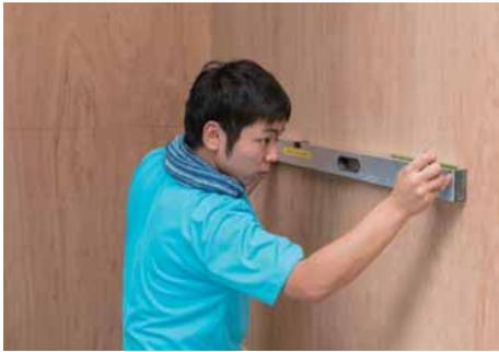
正面の陸墨を墨出しするための水平基準を決める。
