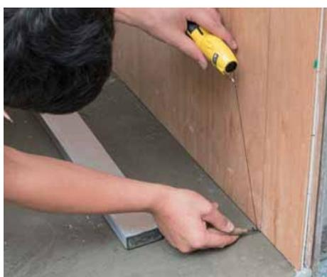
正面に向かって右側の地墨を墨出しする。正面右側の垂直墨と床面タイル割付け（側面左側）終点とを結ぶ。
