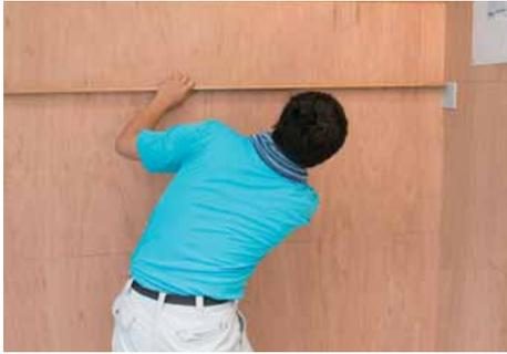
正面の入隅端面にタイルを仮止めし直し、側面上部のタイル割付けを行う。
